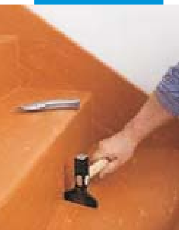
Detail uhlazení krytiny z PVC
