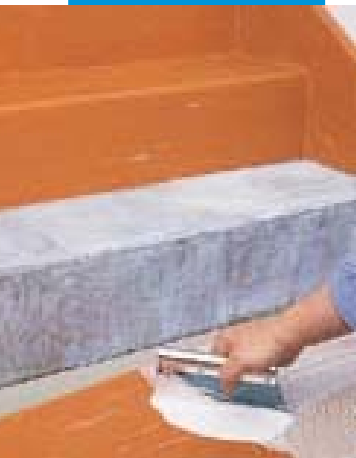
Nanášení Ultrabondu Aqua-Contact na rubovou stranu krytiny z PVC
