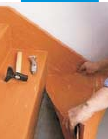
Pokládka krytiny z PVC
