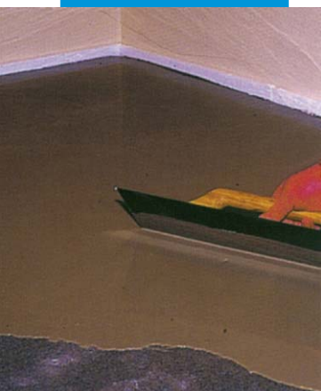
Zpracovávání Novoplanu 21 pomocí hladítka na cementovém potěru, ošetřeném základním nátěrem Primer G
