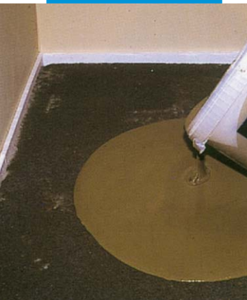
Nanášení Novoplanu 21 na podklad
