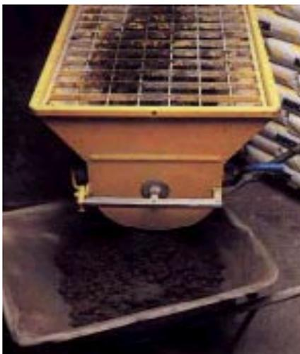
Potěry s **MAPECEM**em se zhotovují stejnou technologií jako potěry tradiční: zhotovení pásů v požadované rovině, položení směsi, její důkladné zhutnění a vyrovnání do výsledné plochy. Podél zdí místností, okolo sloupů apod. se doporučuje vytvořit 1 cm širokou dilatační spáru z pružného materiálu (např. korek, polystyren apod.).
